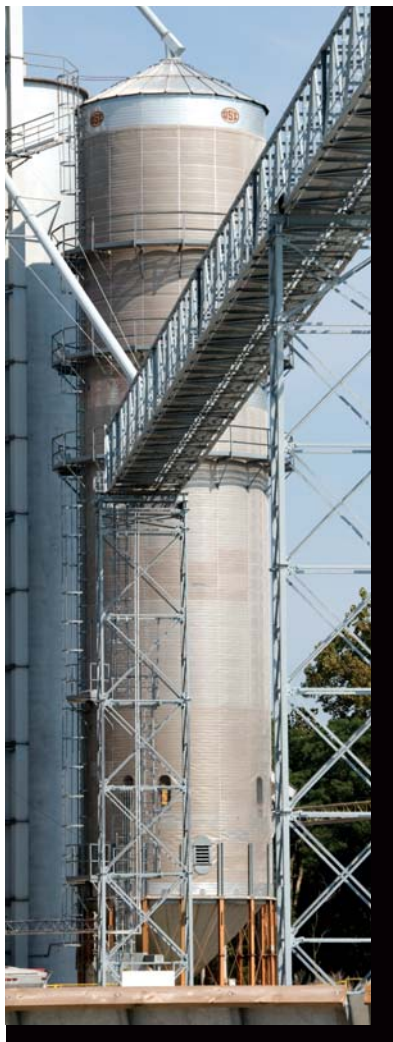
2400 12' dia. x 85'-5" h. 19' dia. w/Catwalks
